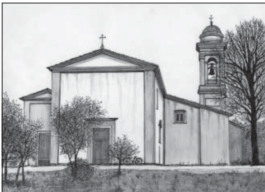
Fucecchio, località Querce (Firenze) – Parrocchia San Nazario - Santuario Madonna delle Querce. Nella posizione strategica della Via Francigena sull'attraversamento dell'Arno, l'antica chiesa di San Nazario (da cui il nome del luogo Serrazzara ) era presente già dall'866. L'attuale edificio risale al 1639 e ricorda altresì la miracolosa apparizione della Vergine nella seconda metà del XVI secolo.
