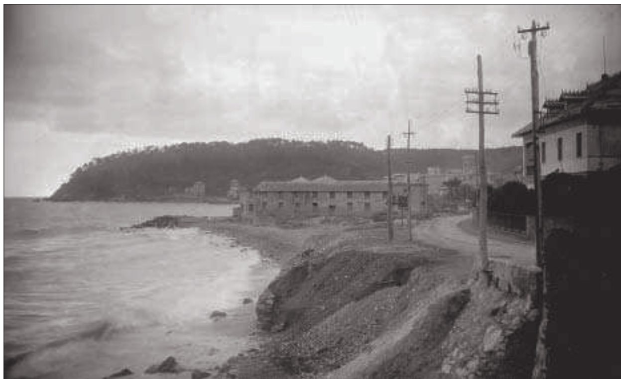
Anno 1929 - Panoramica dalla Maloa col cantiere Barbieri. Nonostante la strada nazionale sia ancora in terra battuta, i pali di legno sorreggono già le mensole con i cavi delle linee telefoniche. La costa è chiaramente alla mercé delle mareggiate.
