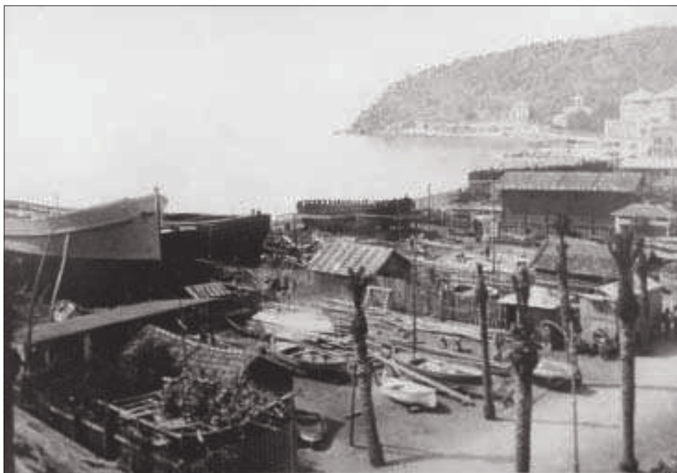
Anno 1929 - Cantieri navali che si estendono dal Cantarena alla spiaggia davanti al vecchio municipio (palazzo Sant'Antonio). In primo piano il rimorchiatore abbandonato e due chiatte (la prima ultimata e la seconda in costruzione). Seminascosto dalla baracca di cantiere e prima dei bagni Milano un grosso pontone di servizio portuale. In primo piano le palme con la chioma ridotta ad un esile ciuffo a seguito della gelata di inizio anno. Sulla destra e in basso, l'originale studio fotografico motorizzato del fotografo Rebella con clienti in attesa.
