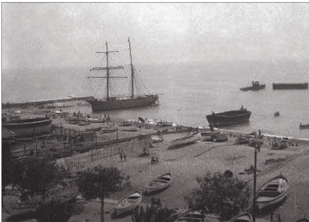
Anni '30 del XX secolo - Dal cantiere dei fratelli Calcagno è stata varata una chiatta e un'altra sta per essere tirata in secco per le necessarie riparazioni. Intanto nei cantieri dei fratelli Barbieri si sta lavorando per ricoverare nello scalo un veliero a due alberi (brigantino goletta o scuna) per la manutenzione richiesta dall'armatore.
