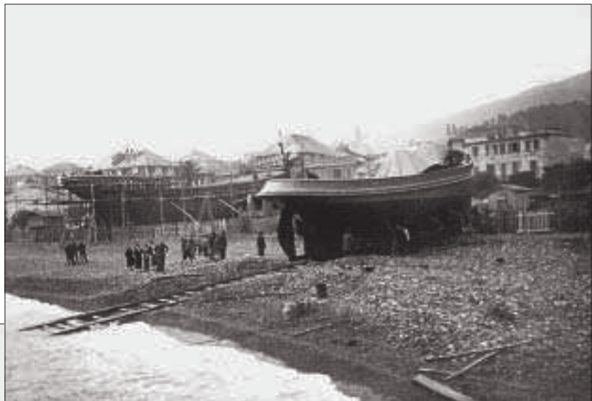
Anni '30 del XX secolo - Demolizione di un veliero nel cantiere Barbieri. Uomini abituati a costruire lavorano di mazza accanendosi a malincuore sulla barca agonizzante, riducendola ad uno scheletro. Ma dalla miniera di legno saranno ricavati preziosi pezzi di ricambio che riprenderanno il mare opportunamente adattati. *
