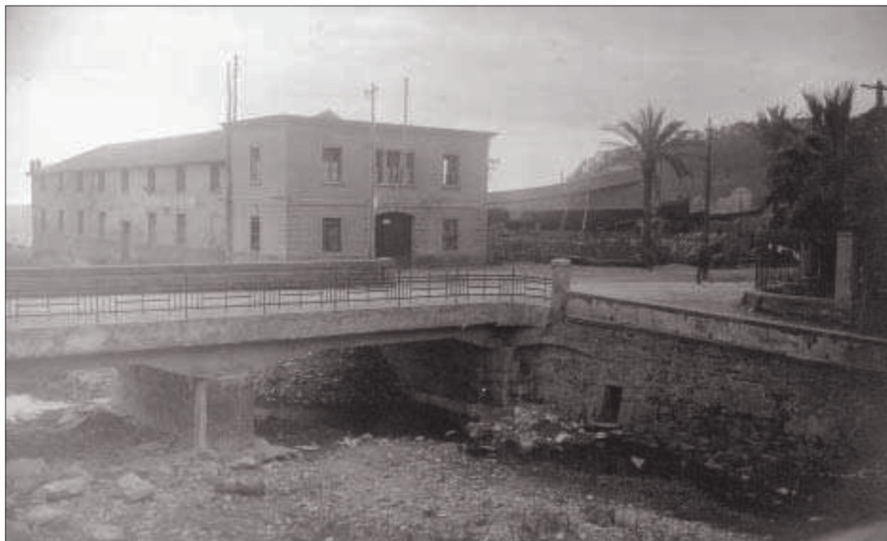
Anno 1930 - Cantiere navale dei fratelli Barbieri presso la foce del rio Cantarena. La costruzione in muratura, oltre alle attrezzature dello scaletto, ospitava la Fabbrica del ghiaccio , che veniva prodotto a listoni distribuiti negli esercizi commerciali del paese. *
