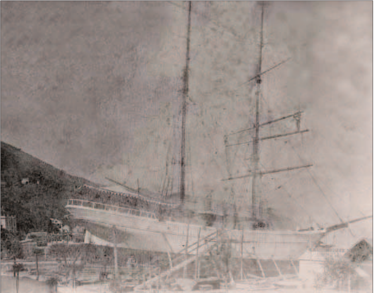
Anno 1894 - Brigantino goletta (detto anche brigoletta o scuna) dei cantieri navali Giovanni Toso pronto al varo. Veliero di piccolo cabotaggio (100-200 ton.), a due alberi (il primo a vele quadre, il secondo a vela aurica), utilizzato prevalentemente sulle rotte mediterranee, anche se navi del genere solcarono spesso gli oceani. Vanto della cantieristica arenzanese. *
